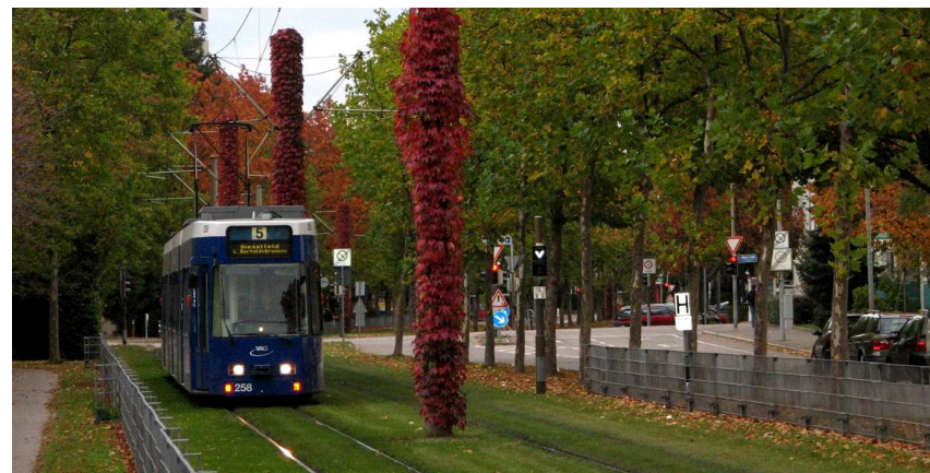
Coberta vegetal als pals de la catenària del tramvia de Friburg de Brisgòvia (Alemanya)
