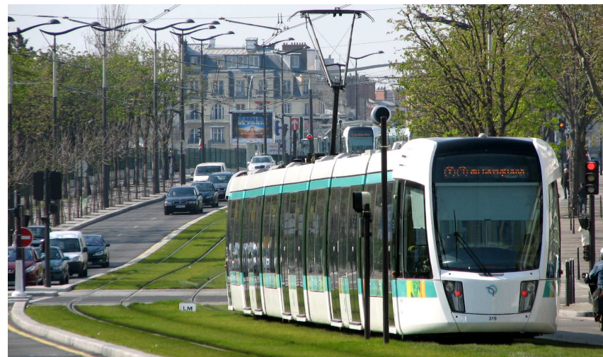
La integració de la catenària a la línia T3 de París s'ha resolt aprofitant els pals de la il·luminària. La subjecció de la catenària és el veritable impacte d'aquest sistema d'alimentació elèctrica, no els cables.
