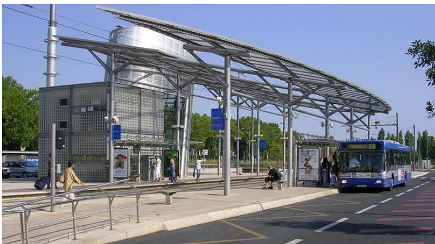
Intercanviador de serveis alineats però amb sentits oposats, entre tramvia i bus a Montpellier.
