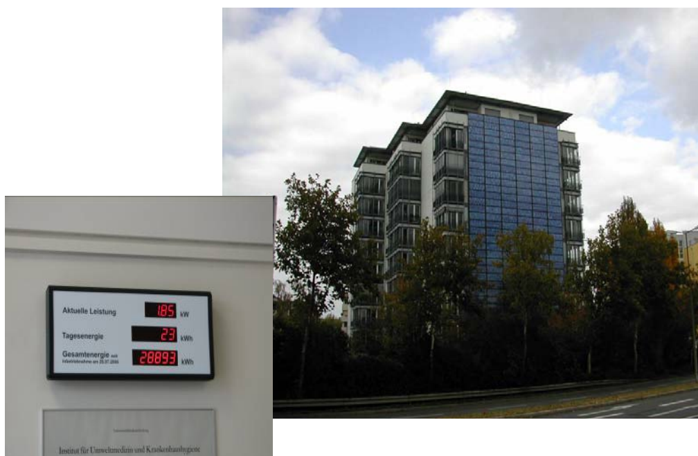
Ilustración 20: Instalaciones fotovoltaicas para financiar la rehabilitación de un edificio de vivienda de protección social
