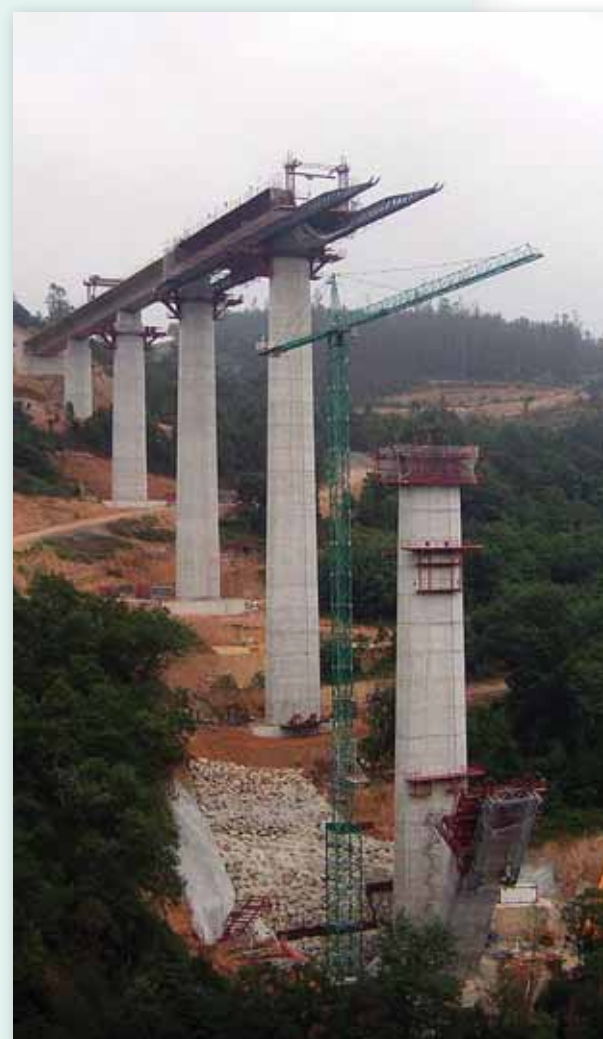
Obras de un viaducto del AVE sobre el río Ulla en Galicia.
