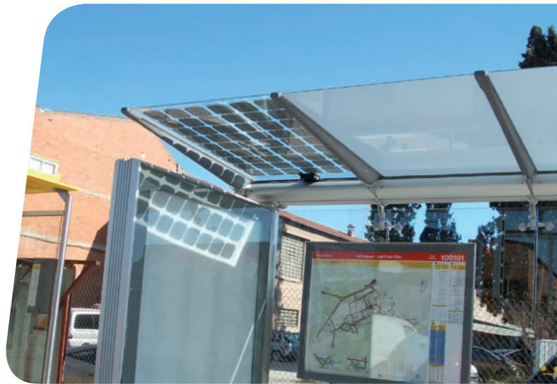
Cèl·lules fotovoltaïques instal·lades en una parada tipus Griwsow
