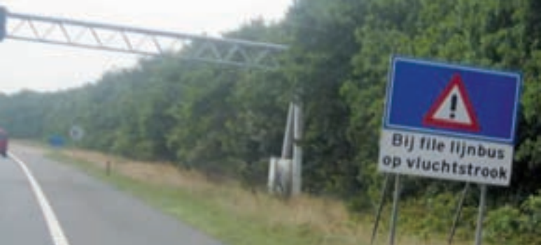
Models d'aprofitament del voral com a carril bus em cas de congestió. A l'esquerra, exemple neerlandès. A la dreta, exemple suec.
