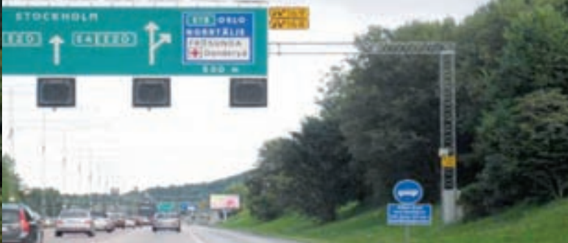
Models d'aprofitament del voral com a carril bus em cas de congestió. A l'esquerra, exemple neerlandès. A la dreta, exemple suec.
