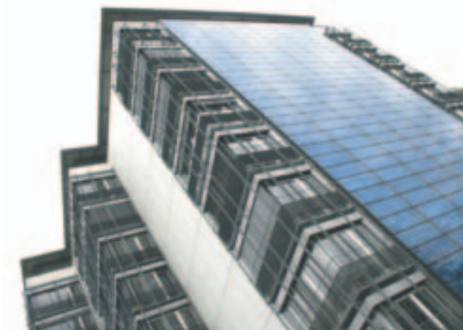
Edifici dels anys setanta, reformat amb nous panells solars
