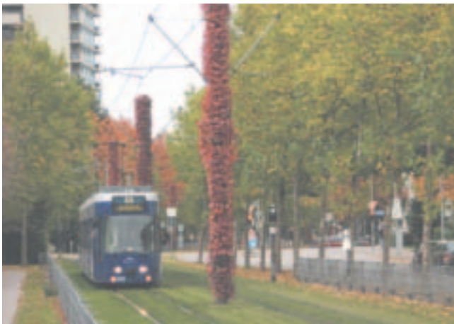
La integració de les infraestructures és molt acurada. Tant les tanques com els pals de la catenària apareixen recoberts de vegetació
