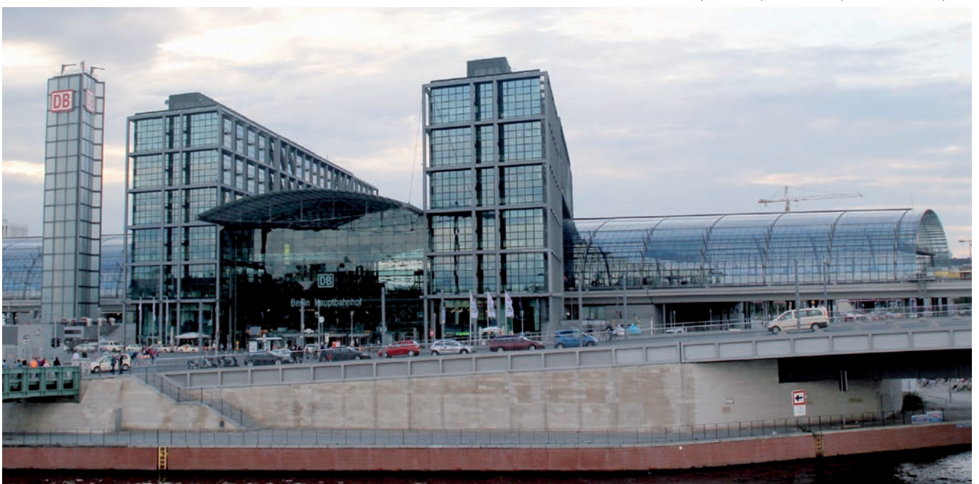
Hauptbahnhof (estació central) al costat del riu Spree.
