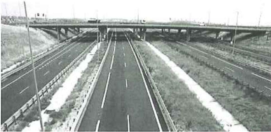
Entrada a Madrid de la autopista de peaje R5 . -
