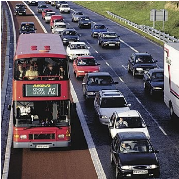
Reforma de la xarxa Adaptació viària de la T11
