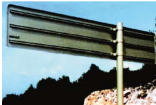
Imatge 11.- Reforç perimetral amb doble plec
