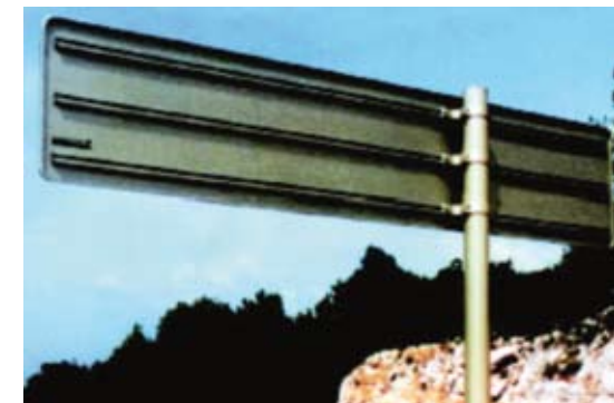
Imagen 11.- Refuerzo perimetral con doble pliegue
