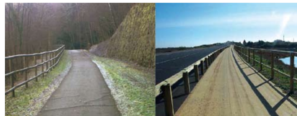
Imagen 16.- Barreras de contención de madera en vías ciclistas
