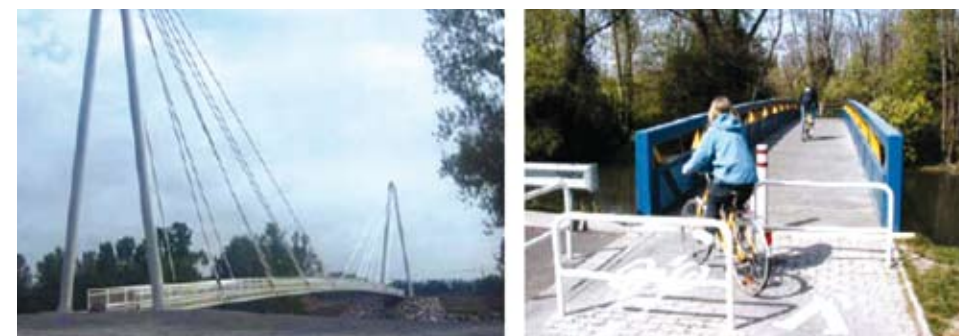
Imagen 4.- Pasarelas de vías ciclistas
