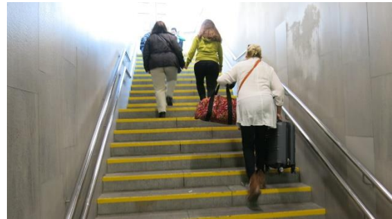
Una mujer cargada con equipaje ante el no funcionamiento del equipo empieza a subir el primero de los tres tramos de los 30 escalones.
