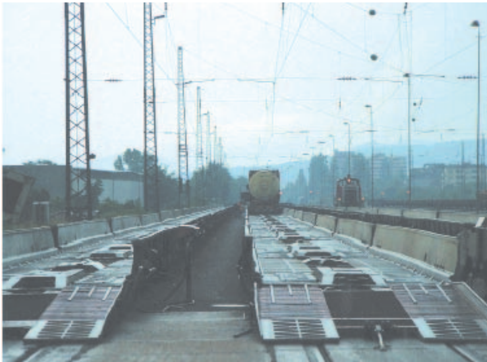
Plataforma d'accés dels camions al ferrocarril.
