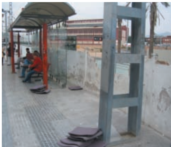
Aquest mur impedeix fer el transbordament entre el metro i el ferrocarril
