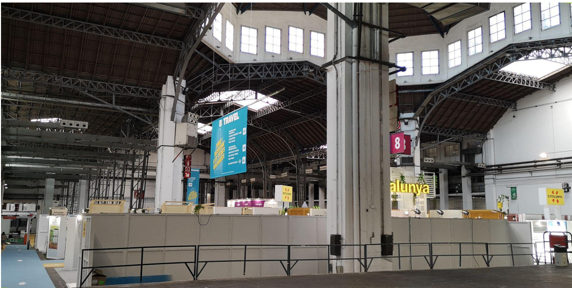
Palau de la Metal·lúrgica de la Fira de Barcelona
