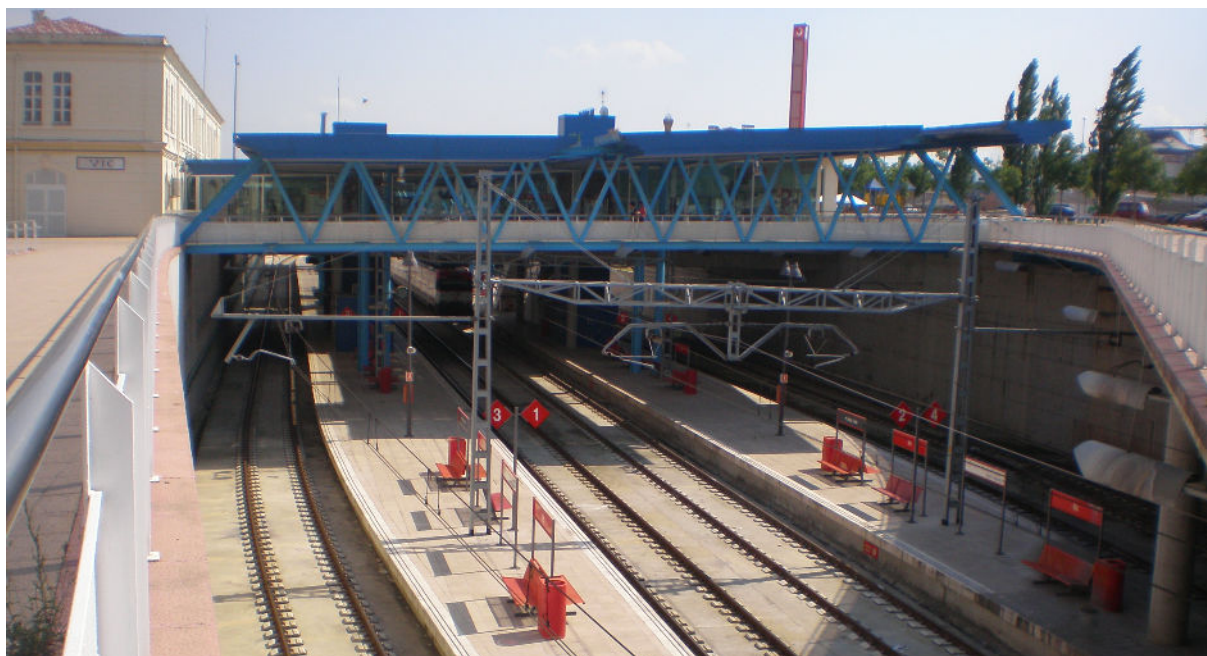
Vista de la estación de Vic, después del soterramiento en trinchera. Fuente: Wikipedia
