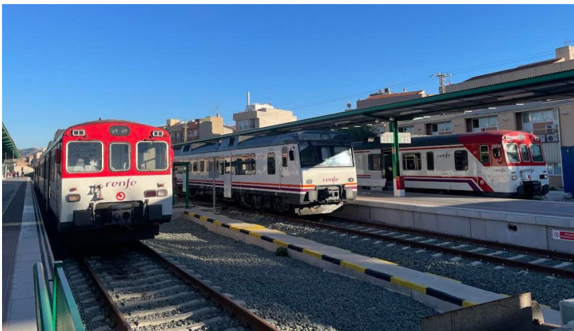
Estación provisional de Murcia del Carmen para trenes de ancho convencional
