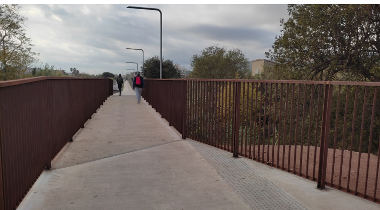
Pas superior de la nova infraestructura per la mobilitat activa sobre la riera dels Canyars, al terme municipal de Gavà. Es pot observar l'estretament de la zona de pas, que han de compartir vianants i ciclistes o persones usuàries de VMP.
